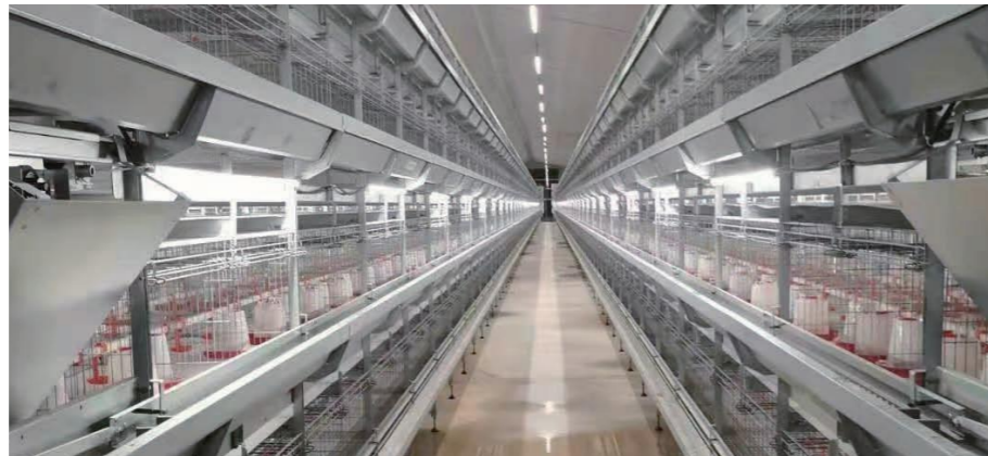
优点: 无频闪 减少压降 光照均匀 每层光照达60LUX+ (图片拍摄于100%亮度)
