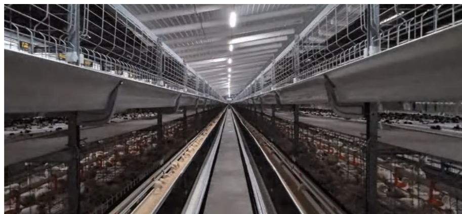
优点: 无频闪 无压降 光照均匀 发光角度大, 食槽走道安装食槽光照达到, 捉鸡处每层大区域进光。(图片拍摄于12%亮度)
